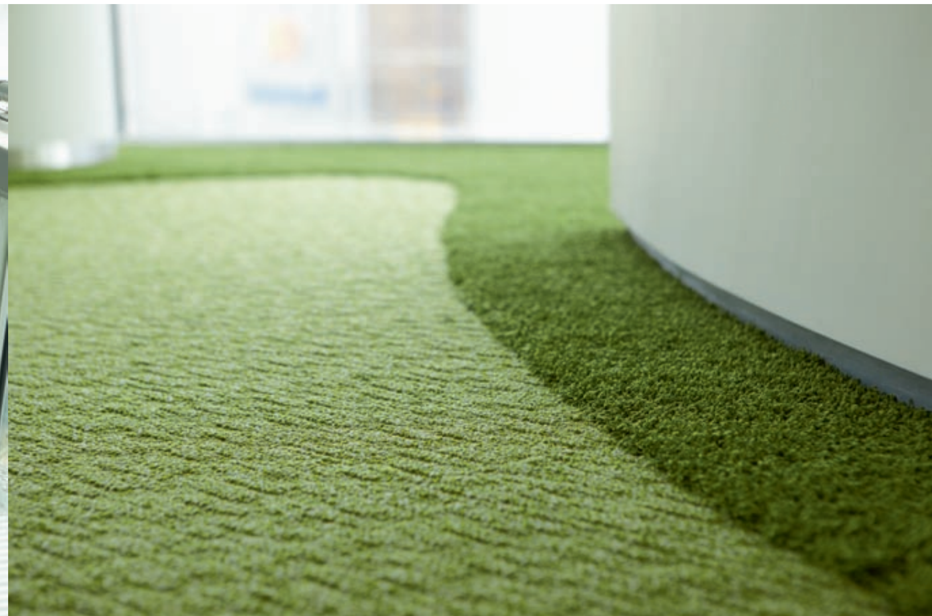
Hoogpolig tapijt in de werkplekruimtes. Het laagpolige tapijt ligt in de doorgaande paden en in de ontmoetingsplekken.
